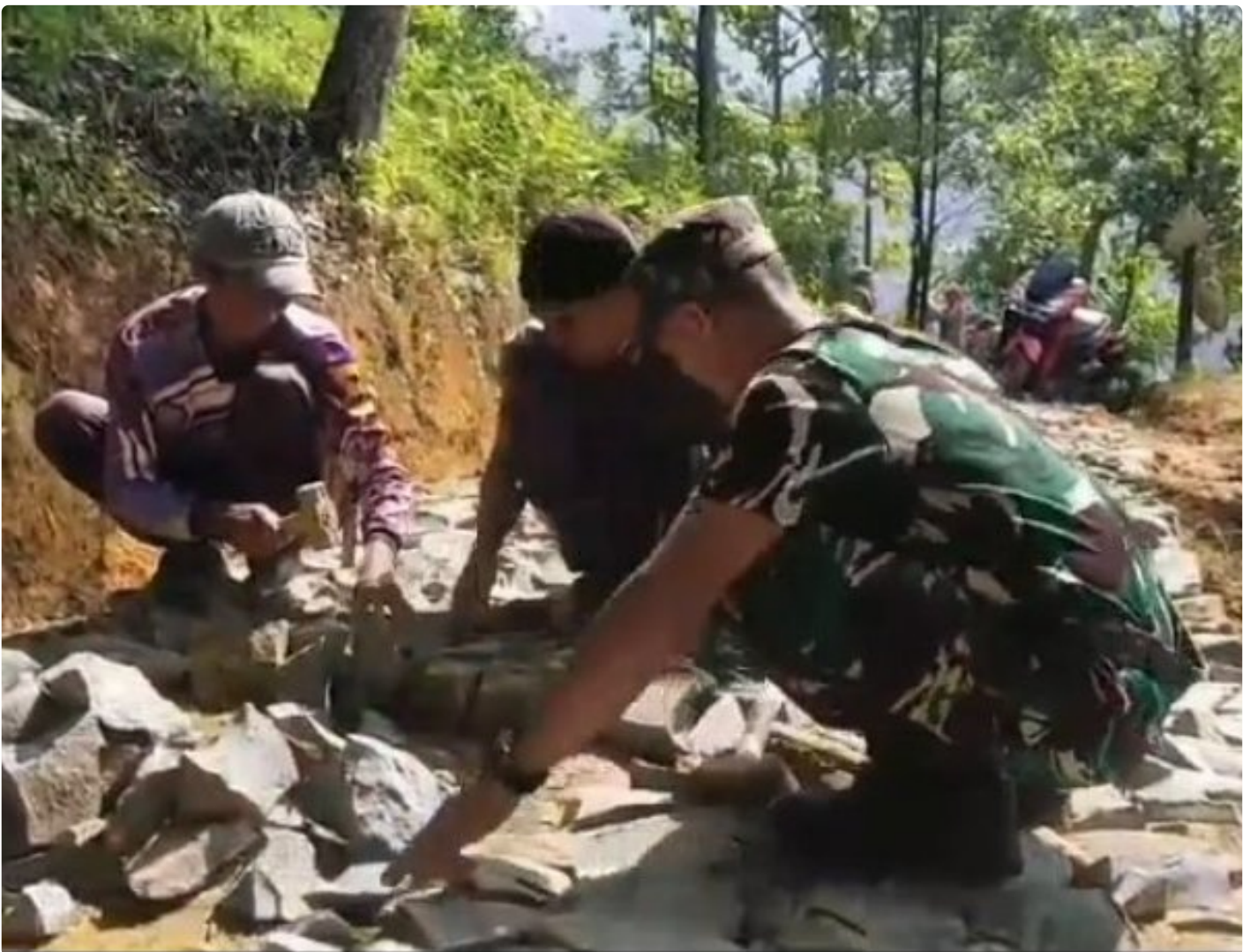
Gotong royong membangun jalan
